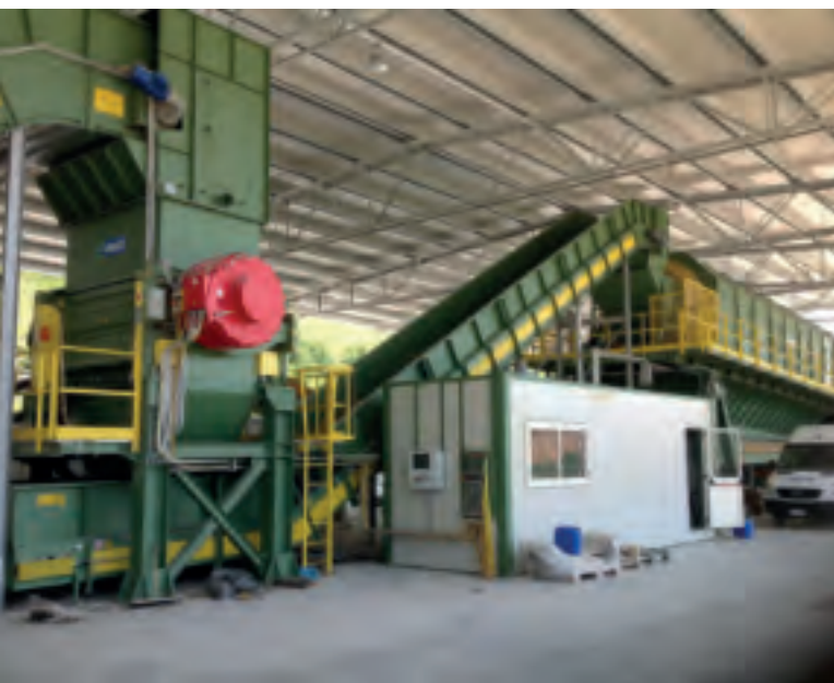
Линия сортировки ТБО 60 тонн/час - MSW sorting line 60 ton/h
