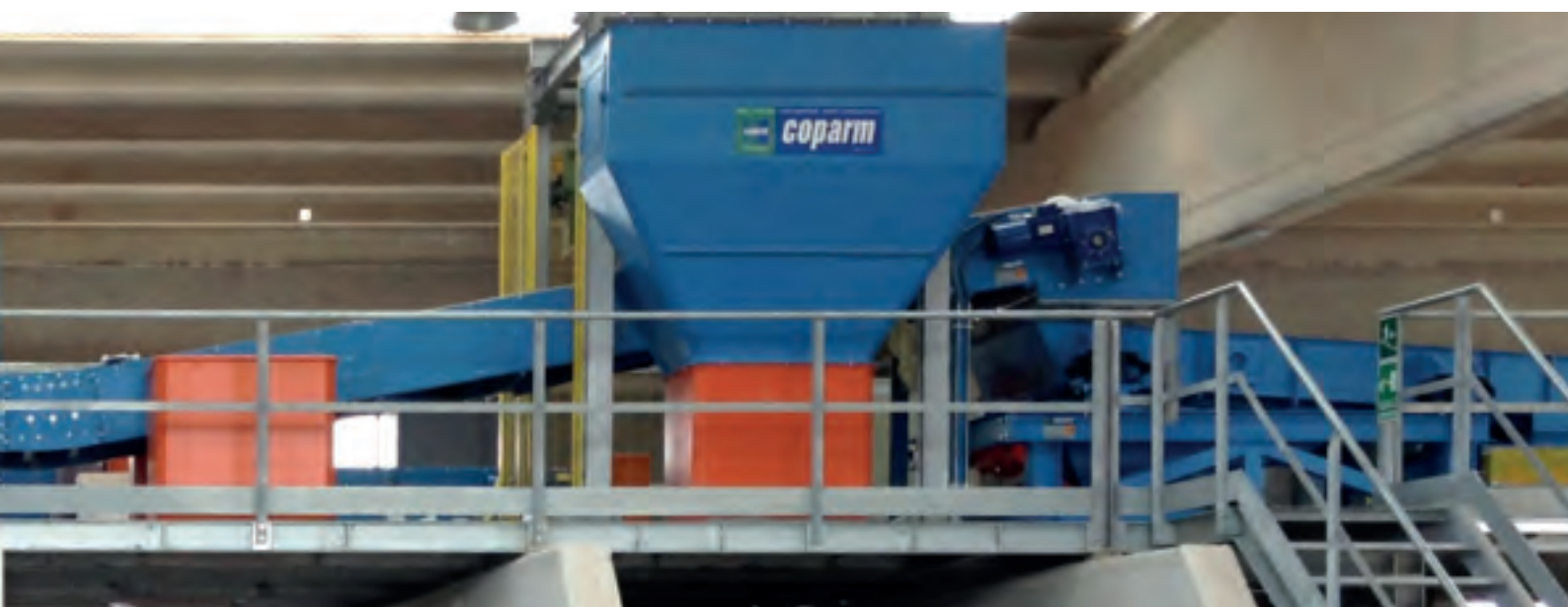
Линия сортировки не разделенных отходов - Multimaterial sorting line
