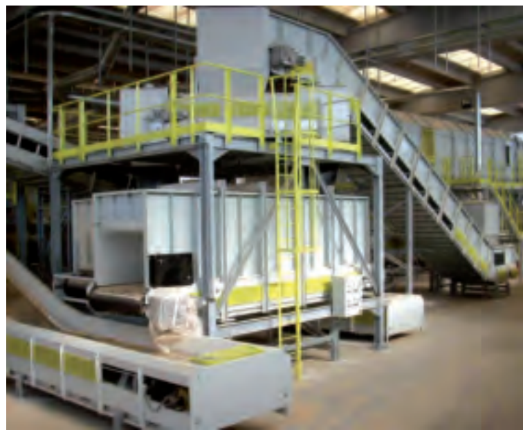
Линия для производства RDF CDR feeding and production line
