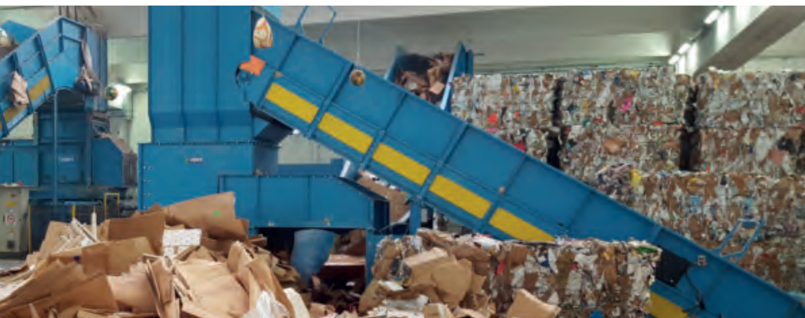
Измельчение и прессование бумажных отходов непригодных для вторичной переработки - Waste paper shredding and baling plant
