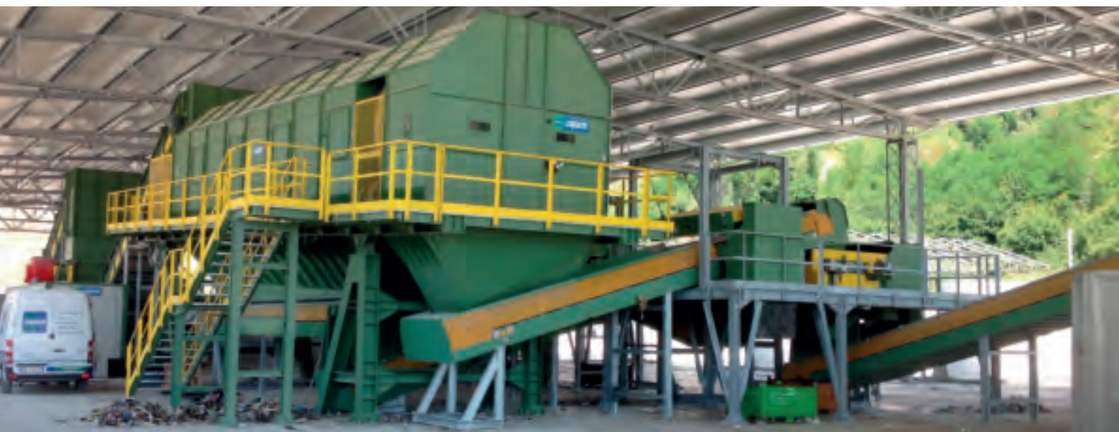
Линия для переработки ТБО 50-60 тонн/час - MSW treatment plant 50-60 ton/h
