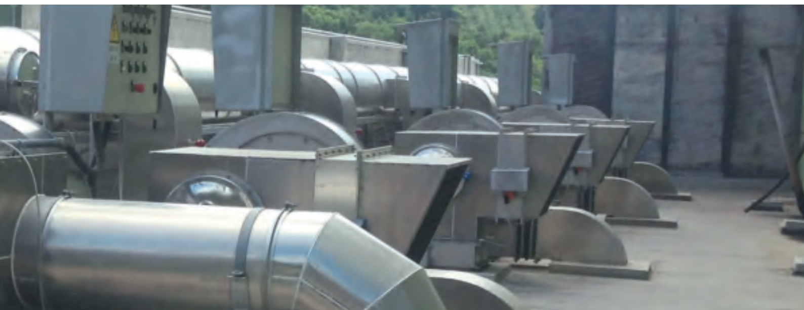
Установка биостабилизации ТБО - MSW waste biostabilization plant
