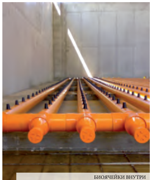
СИСТ.ОЧИСТКИ ВОЗДУХА УСТ. БИОСТАБИЛИЗАЦИИ
